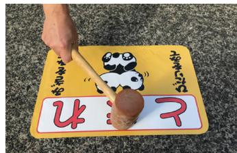
④ゴムハンマーで中心から外側へ渦巻きを描くように叩き、最後エッジを入念に叩き路面に馴染ませます。
